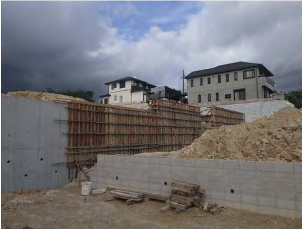
尾張旭市柏井町造成工事 ゼロ災害で進行中
