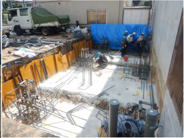
(株)アジケン 社屋増築工事 ゼロ災害で進行中
