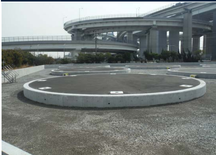
CTT南タンク基礎工事 ゼロ災害で進行中
