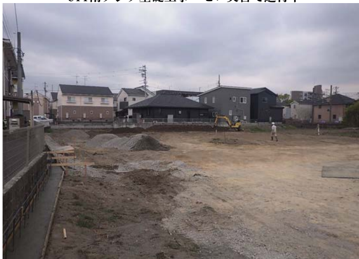
清須開発工事 ゼロ災害で進行中
