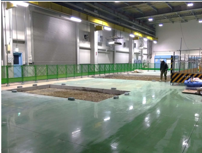
中庸スプリング碧南工場増設工事 ゼロ災害で進行中
