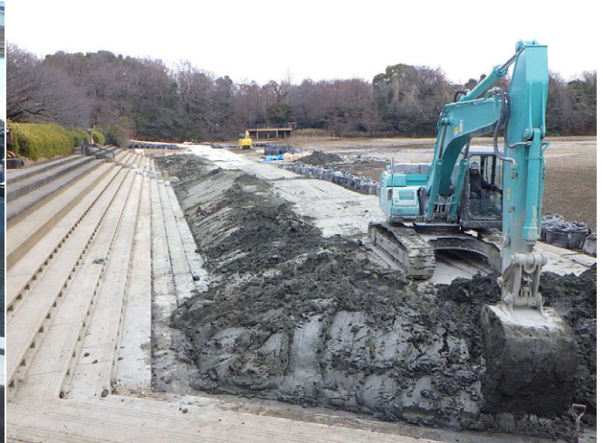
水広下池耐震補強工事 ゼロ災害で進行中
