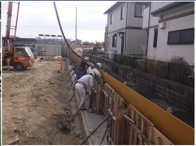
角文第二社屋新築工事 ゼロ災害で進行中
