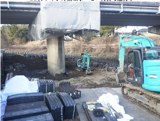
喜惣治橋補強工事 ゼロ災害で進行中
