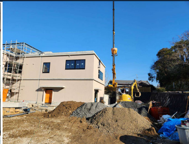
SOUPタウン外構工事 ゼロ災害で進行中
