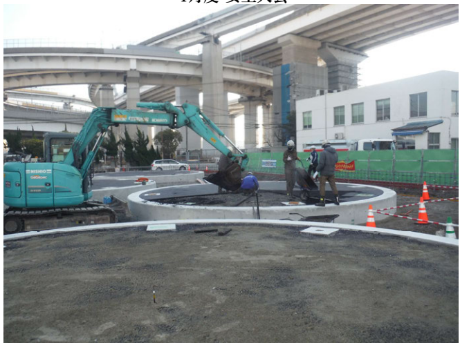
CTT南タンク基礎工事 ゼロ災害で進行中
