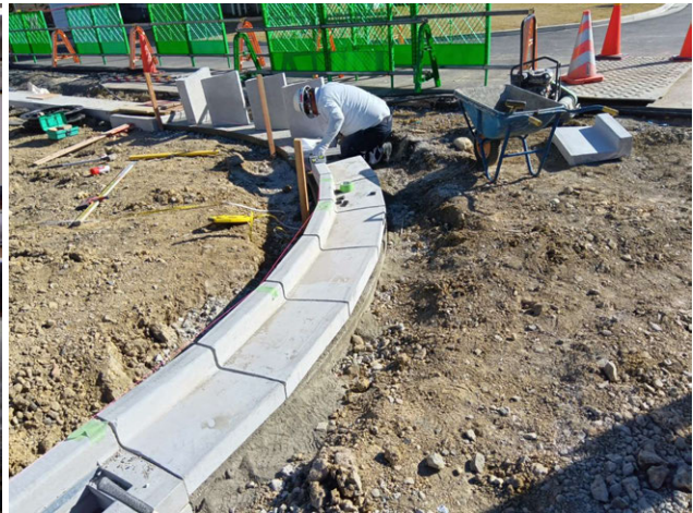
守山自衛隊宿舎改修工事 ゼロ災害で進行中
