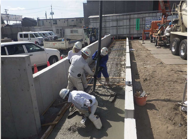
カルティア尾張横須賀外構工事 ゼロ災害で進行中
