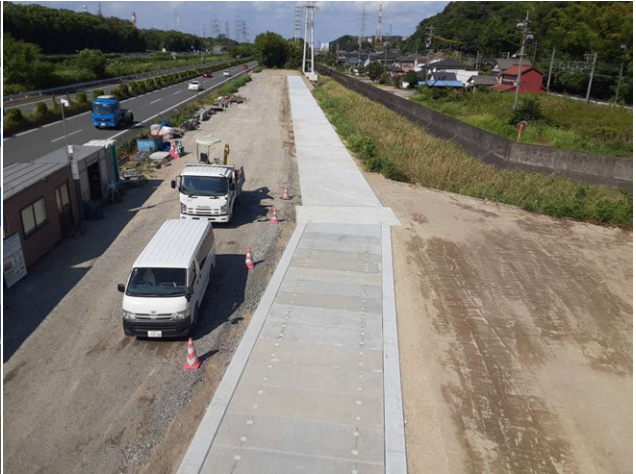
汚水幹線補強工事 ゼロ災害で完了
