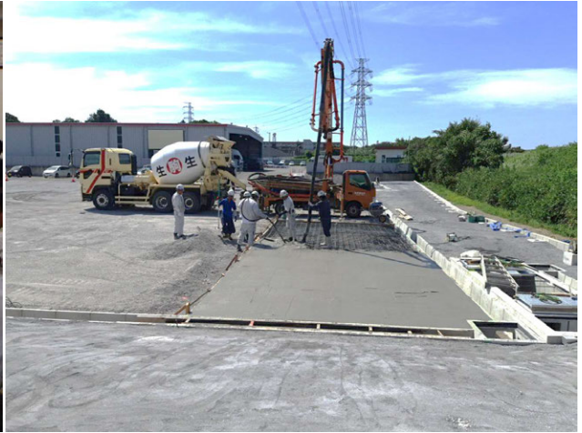
南星キヨックス豊田営業所 2期工事 ゼロ災害で進行中
