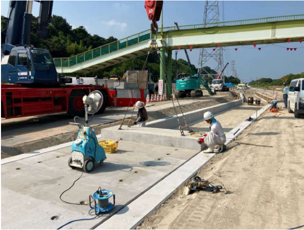
汚水幹線補強工事 ゼロ災害で進行中
