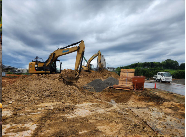
ながね保育園新築工事 ゼロ災害で進行中
