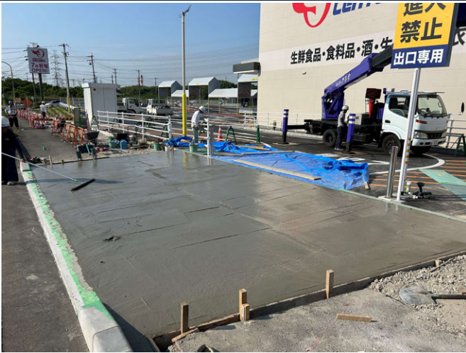
オークワ知多外構工事 ゼロ災害で進行中
