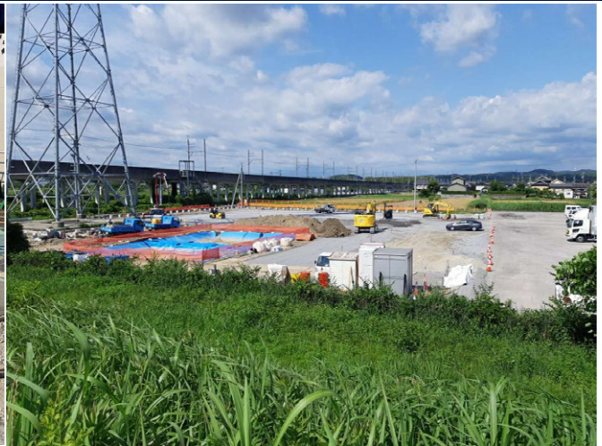
南星キャリックス豊田営業所 2期工事 ゼロ災害で進行中
