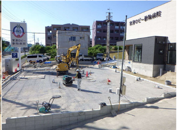
常滑ロビー動物病院外構工事 ゼロ災害で進行中
