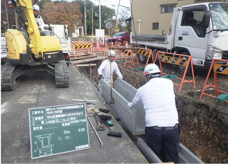
山の手線街路築造工事(その5) ゼロ災害で進行中
