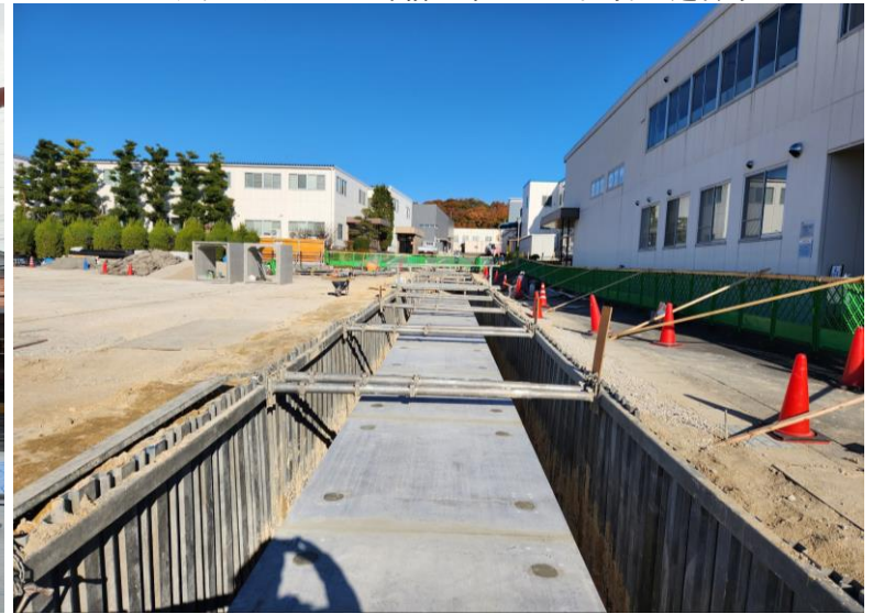
旭サナック外構工事(2期) ゼロ災害で進行中
