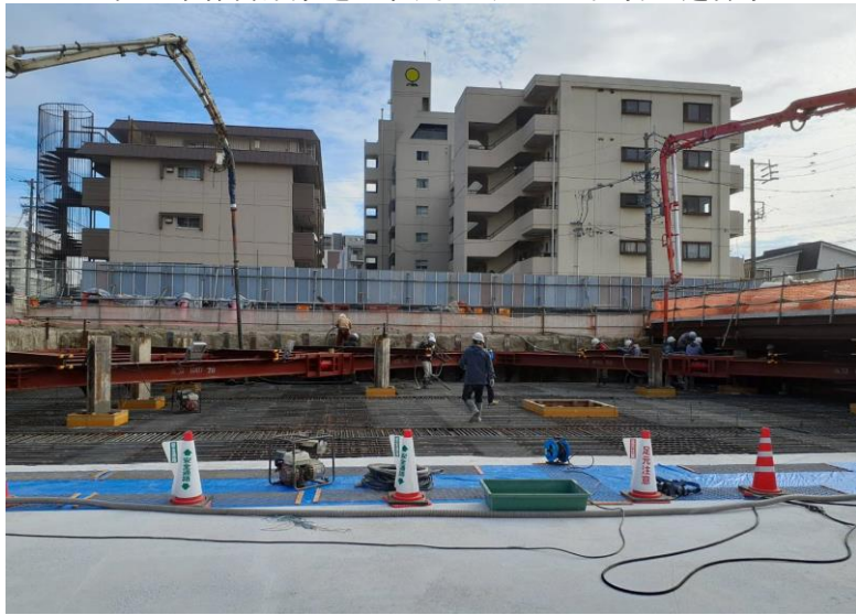
大矢公園調整池設置工事 ゼロ災害で進行中
