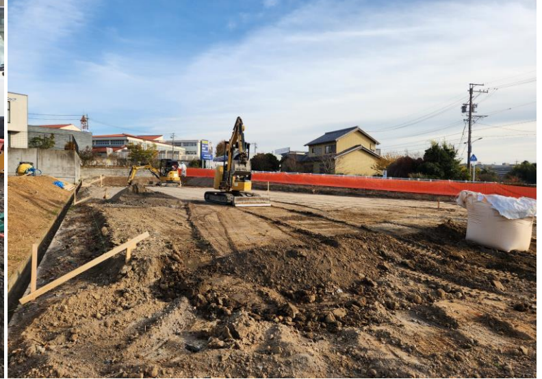
いみずクリニック外構工事 ゼロ災害で進行中
