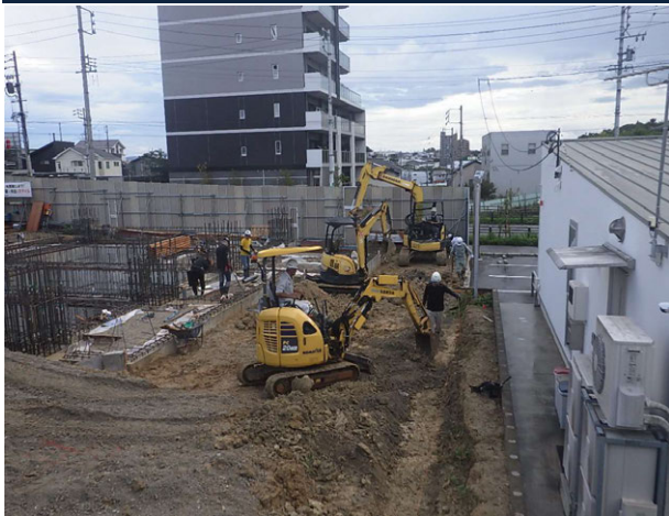
ブラセション日進赤池外構工事 ゼロ災害で進行中
