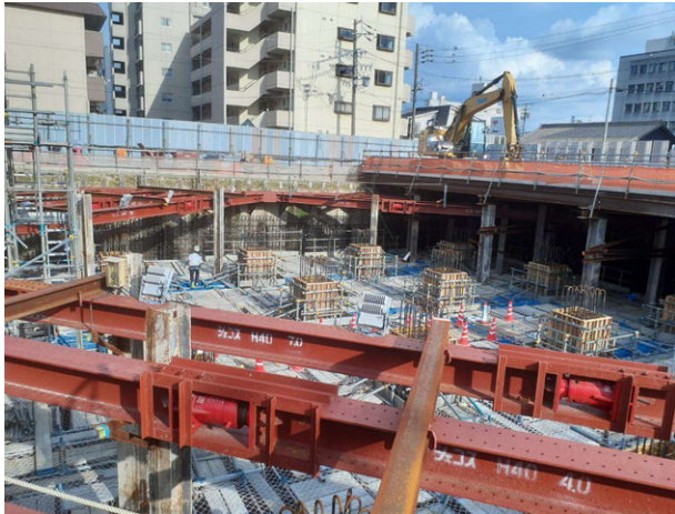
大矢公園調整池設置工事 ゼロ災害で進行中
