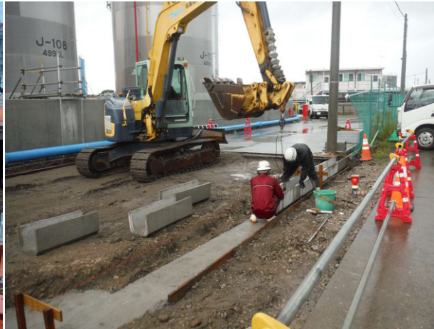
CTTタンク基礎新設工事 ゼロ災害で進行中
