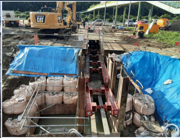
汚水幹線補強工事 ゼロ災害で進行中
