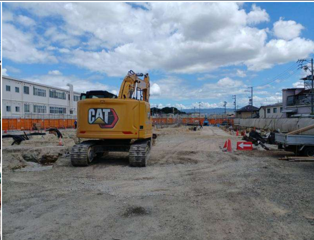
旭サナック共同溝工事 ゼロ災害で進行中
