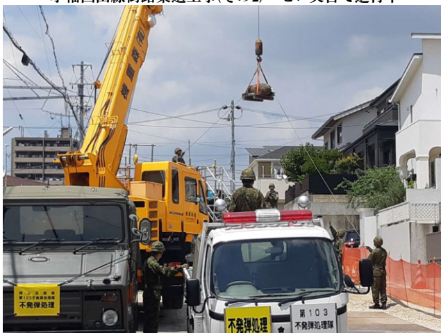
不発弾処理工事(緊急) ゼロ災害で進行中
