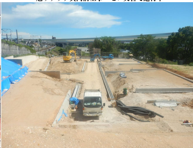
緑区清水山開発工事 ゼロ災害で進行中
