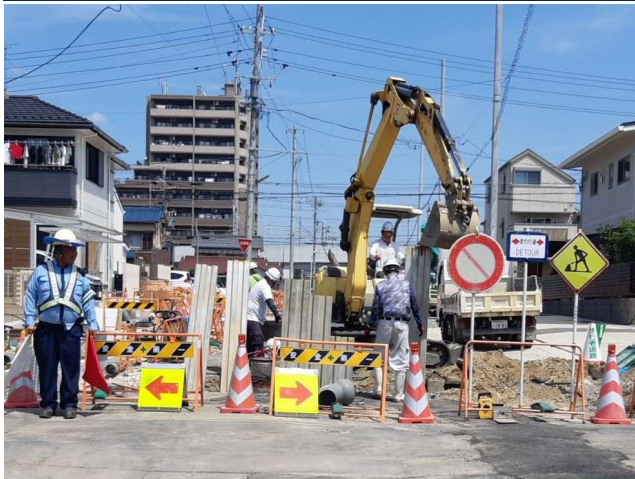
小幡西山線街路築造工事(その2) ゼロ災害で進行中
