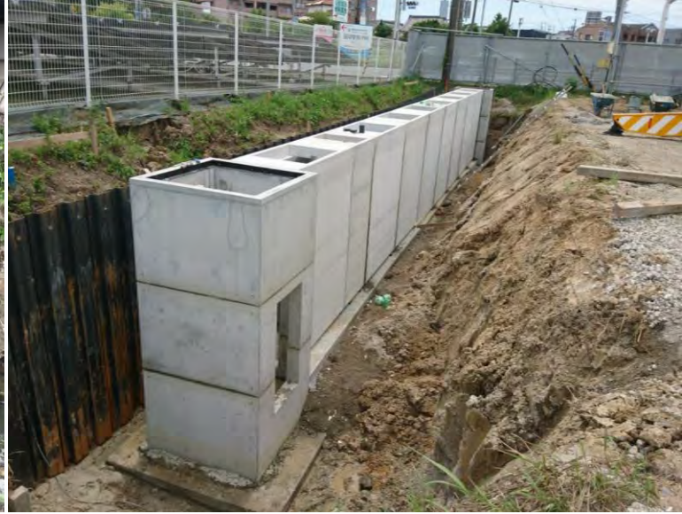
(株)ワークアッププラザ新築工事 ゼロ災害で進行中
