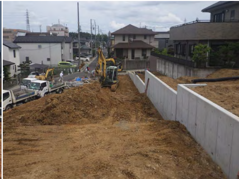
天白区荒池造成工事 ゼロ災害で進行中
