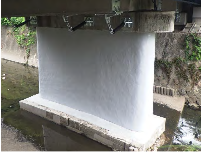
新橋(昭和)補強及び補修工事 ゼロ災害で進行中
