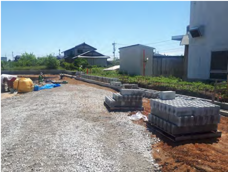
名興発条造成・外構工事 ゼロ災害で進行中
