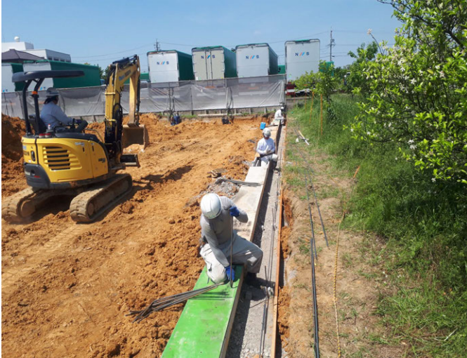
名興発条造成・外構工事 ゼロ災害で進行中
