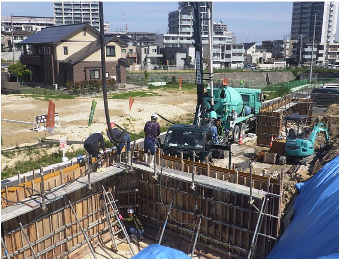
日進市赤池造成工事 ゼロ災害で進行中
