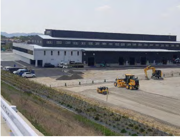
水谷産業 多治見工場新築工事 ゼロ災害で完了
