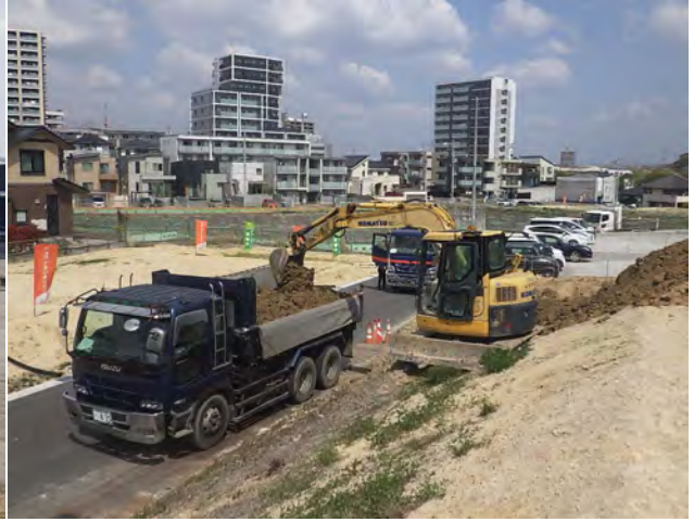
日進市赤池造成工事 ゼロ災害で進行中
