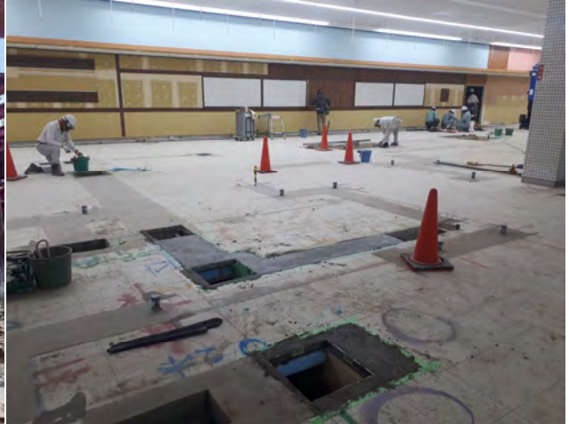
フィール春日井店外構工事 ゼロ災害で進行中
