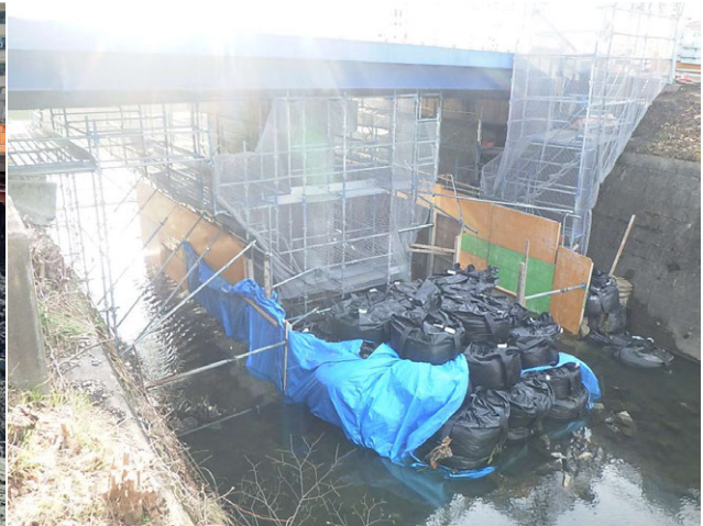
新橋(昭和)補強及び補修工事 ゼロ災害で進行中
