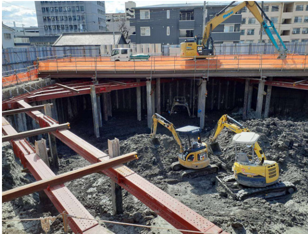
大矢公園調整池設置工事 ゼロ災害で進行中
