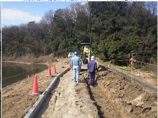
西堀池改修工事 ゼロ災害で進行中
