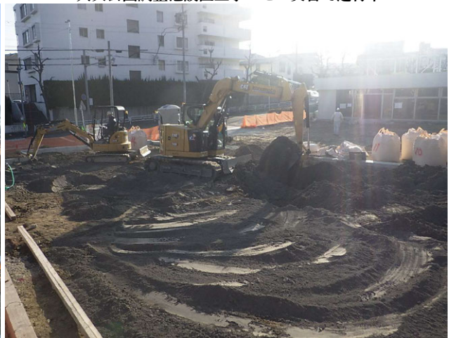
ローソン平和が丘新築工事 ゼロ災害で進行中
