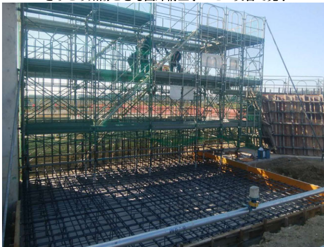
豊田管内道路建設工事 ゼロ災害で進行中
