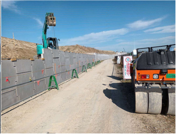
豊田管内道路建設工事 ゼロ災害で進行中
