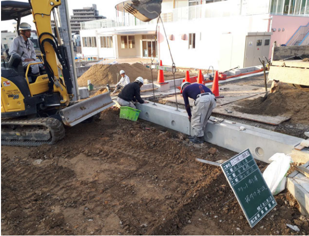
とうごう太陽こども園外構工事 ゼロ災害で進行中
