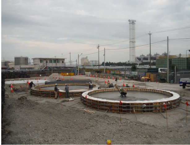
CTTタンク基礎工事 ゼロ災害で進行中
