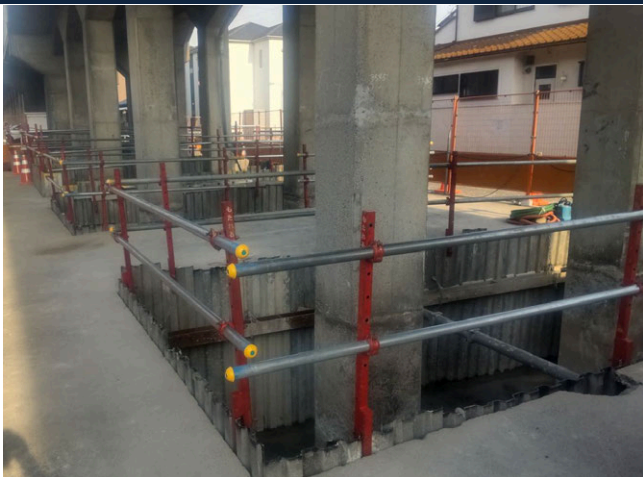
臨港線高架橋耐震工事 ゼロ災害で進行中
