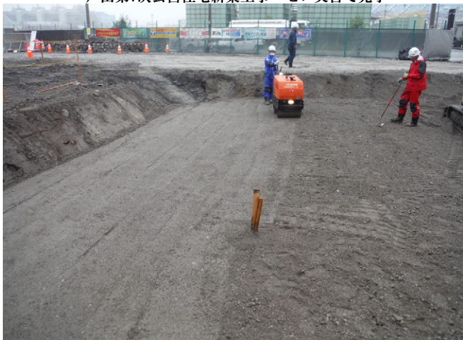
CTTタンク基礎工事 ゼロ災害で進行中
