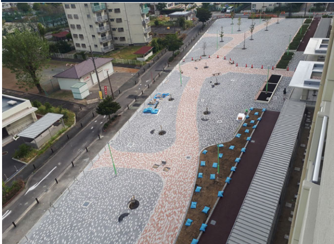
戸田第7次公営住宅新築工事 ゼロ災害で完了
