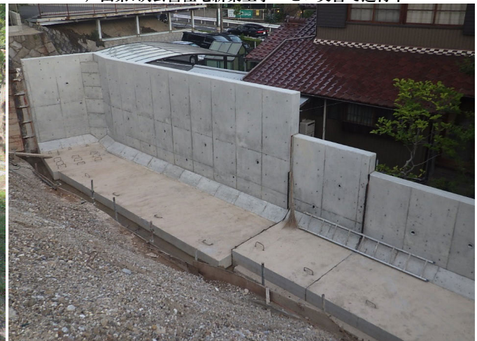
緑区作の山造成工事 ゼロ災害で進行中
