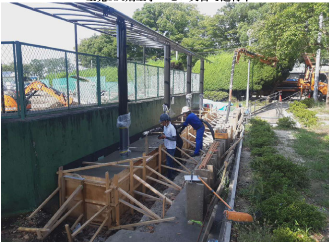
朝宮公園野球場改修工事 ゼロ災害で進行中
