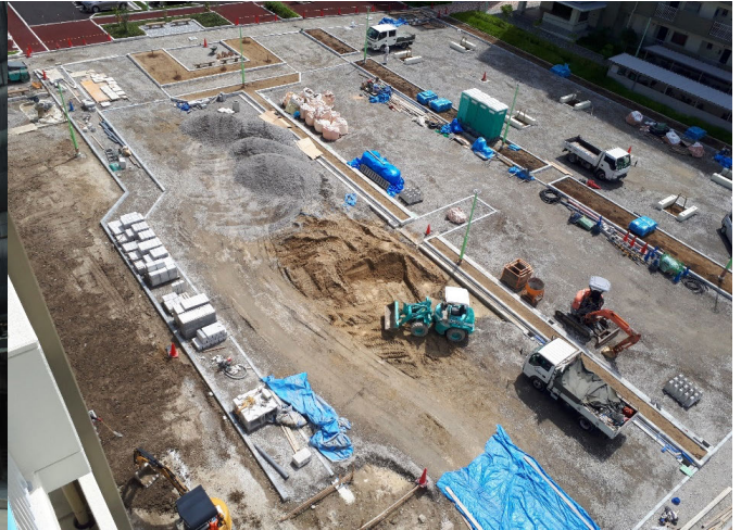
戸田第7次公営住宅新築工事 ゼロ災害で進行中
