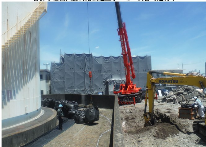
CTTタンク基礎工事 ゼロ災害で進行中
