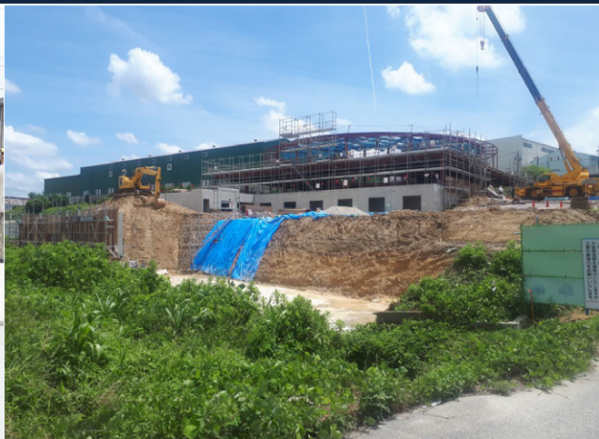
とうごう太陽こども園外構工事 ゼロ災害で進行中
