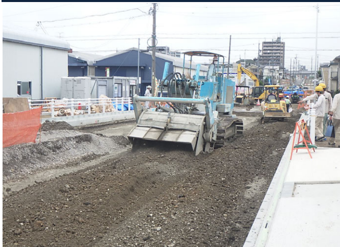
都計小幡西山線街路築造工事 ゼロ災害で進行中
