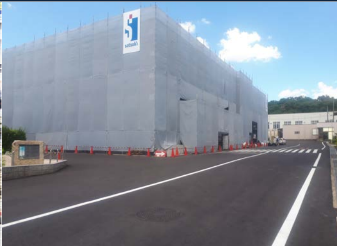
旭サナック受変電室外構工事 ゼロ災害で進行中
