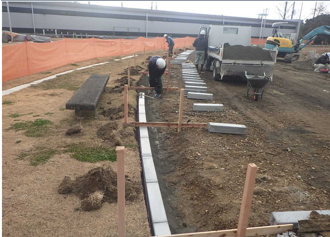
中京大学豊田学舎改修工事 ゼロ災害で進行中
