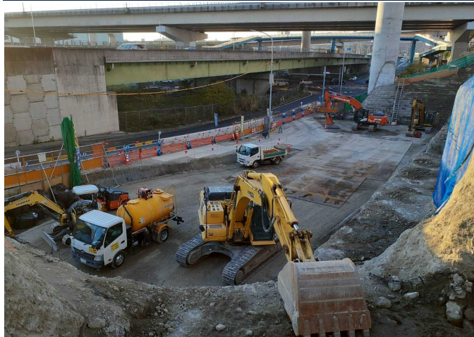
西知多道路(補強土壁撤去工事) ゼロ災害で進行中
