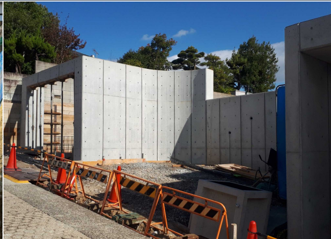
天白区八幡山造成工事 ゼロ災害で進行中
