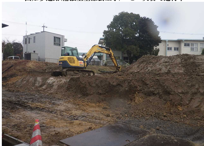
天白区土原造成工事 ゼロ災害で進行中
