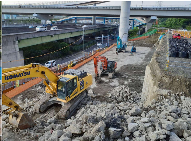
西知多道路(補強土壁撤去工事) ゼロ災害で進行中
