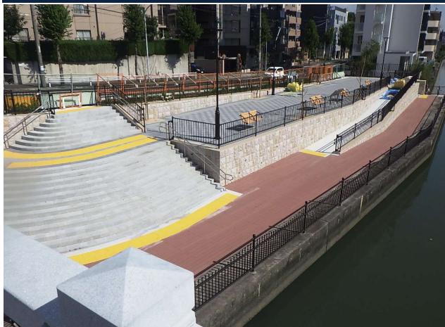
堀川広場整備工事 ゼロ災害で進行中
