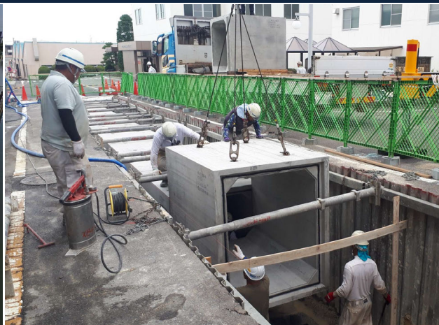
旭サナック排水工事 ゼロ災害で進行中
