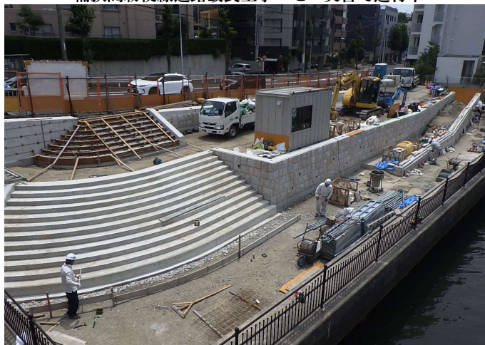
堀川広場整備工事 ゼロ災害で進行中
