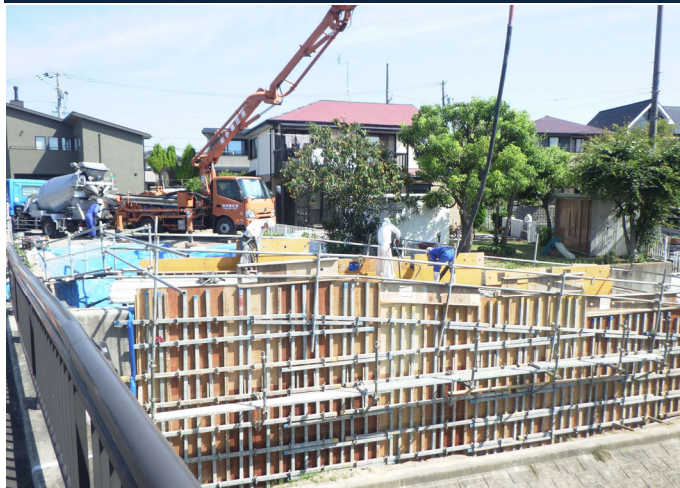
桶狭間勅使線道路改良工事 ゼロ災害で進行中
