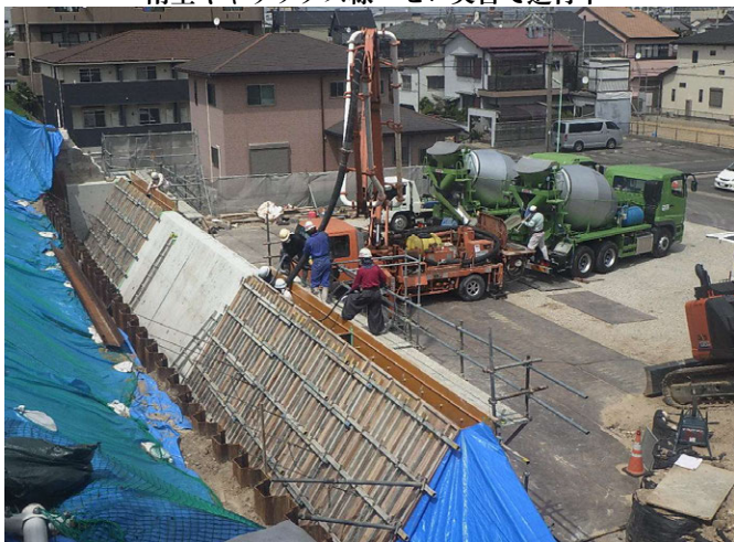
水分橋改築工事 ゼロ災害で進行中
