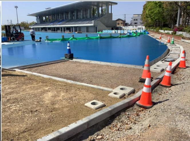
朝宮公園整備工事 ゼロ災害で進行中
