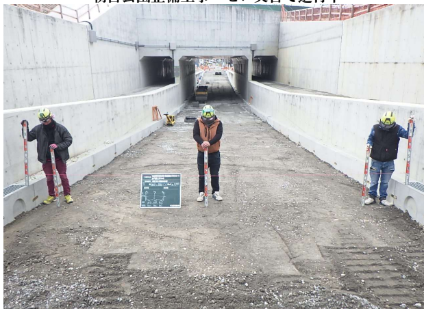
桶狭間勅使線道路改良工事 ゼロ災害で進行中
