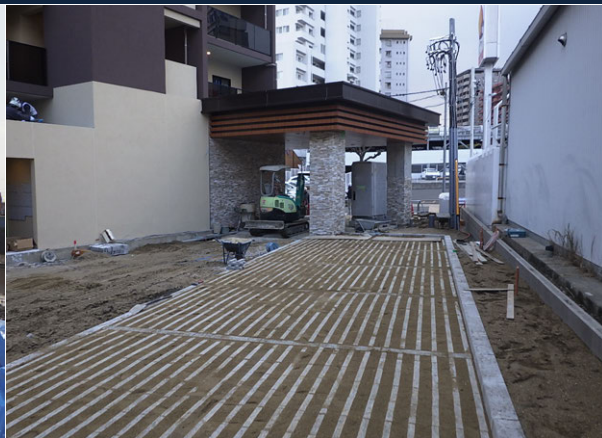
スリーアイランド星ヶ丘外構工事 ゼロ災害で進行中
