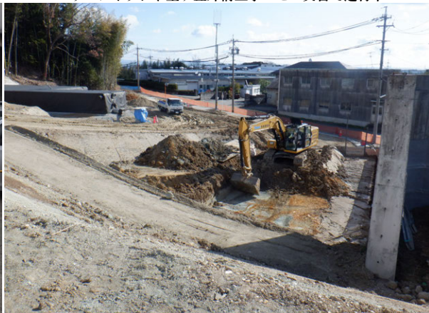
(株)カナザワ様 工場 新築工事 ゼロ災害で進行中
