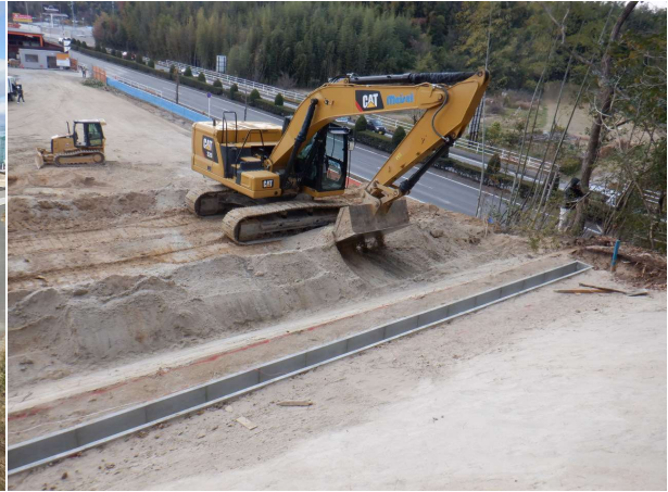
(株)カナザワ工場 新築工事 ゼロ災害で進行中
