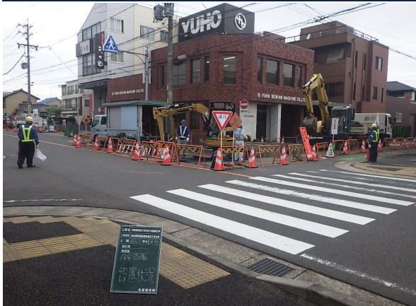
西区枇杷島下水工事 ゼロ災害で進行中
