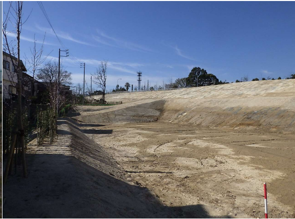
東浦開発工事 ゼロ災害で工事完了
