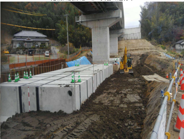
平戸橋整備工事 ゼロ災害で進行中
