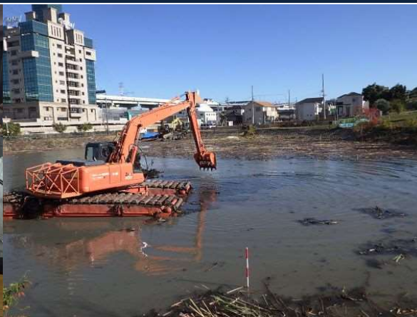
定納山調節池 ゼロ災害で進行中
