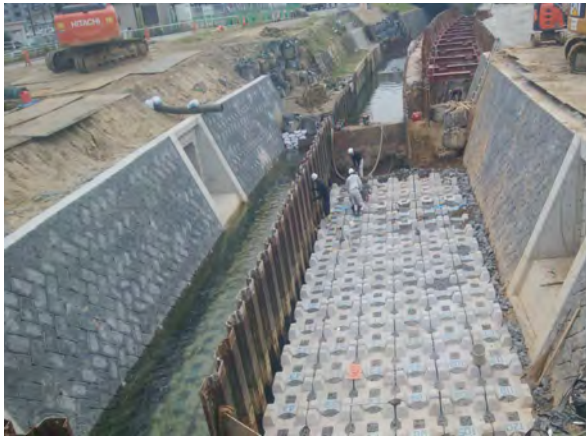
土橋整理 安全作業で進行中
