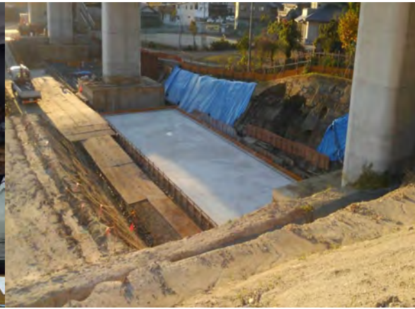
平戸橋整備工事 ゼロ災害で進行中
