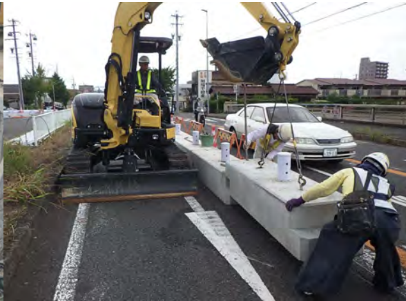
港東橋補強工事 ゼロ災害で進行中
