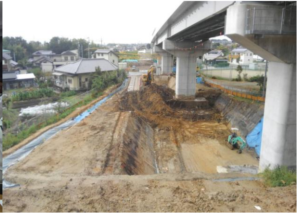
平戸橋整備工事 ゼロ災害で進行中
