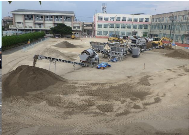
御器所小始め2校運動場整備工事 ゼロ災害で進行中
