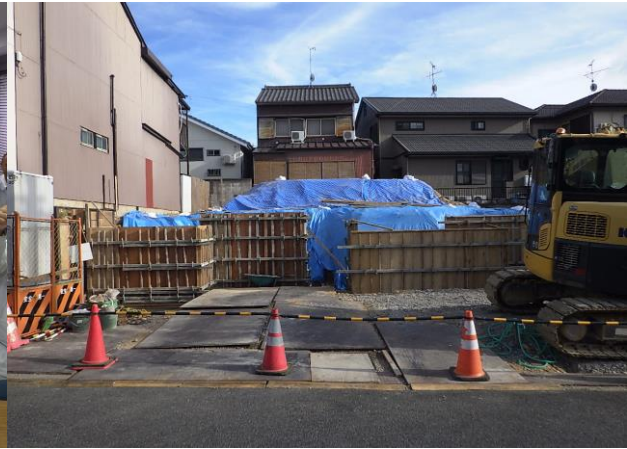
緑区鳴子造成 ゼロ災害で進行中
