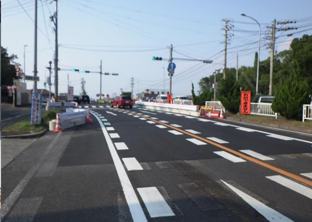
港東橋補強工事 ゼロ災害で進行中
