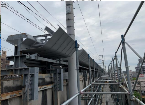
新幹線大規模改修工事 安全作業で進行中
