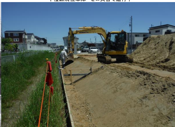
大高瀬木南土地区画整備事業 ゼロ災害で進行中
