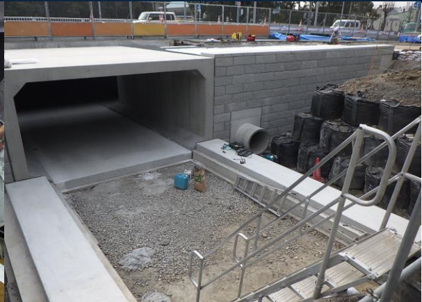
港東橋補強工事 ゼロ災害で進行中
