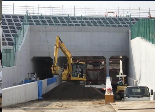
市道桶狭間勸使線第二号道路改良工事 安全作業で進行中
