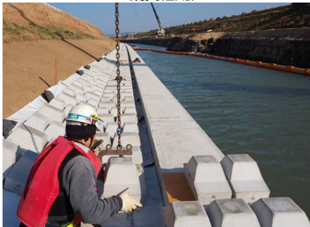
鹿乗川災害復旧 安全作業で進行中
