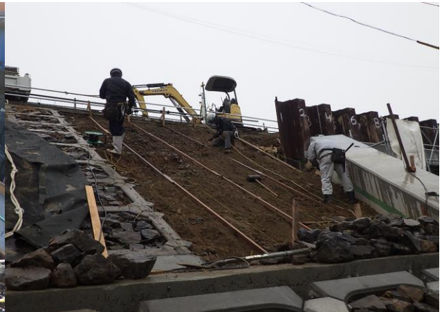
市道桶狭間勅使線第二号道路改良工事 ゼロ災害で進行中
