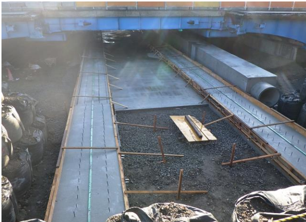
港東橋補強工事 ゼロ災害で進行中
