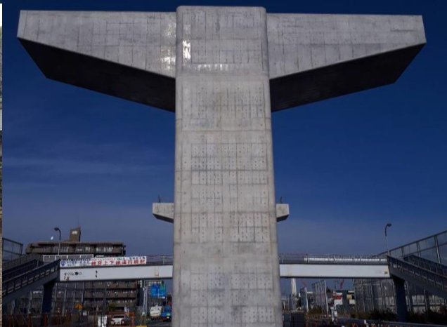
春田4高架橋 完了
