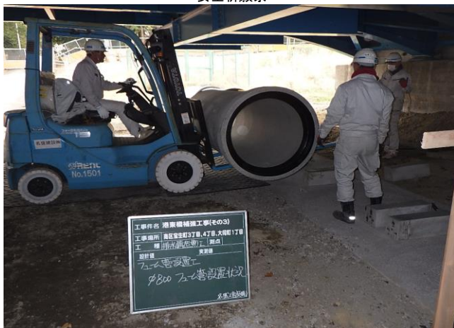
港東橋補強工事 ゼロ災害で進行中
