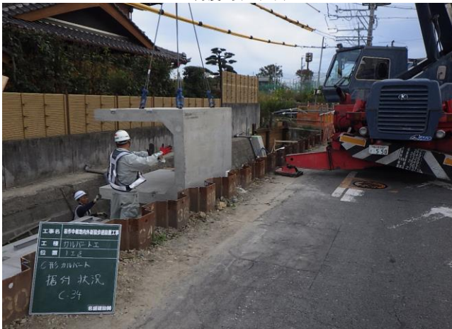
岩作中根地内外新設歩道設置工事 ゼロ災害で進行中
