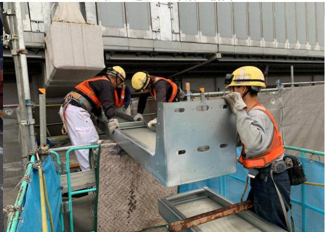
新幹線大規模改修工事 ゼロ災害で進行中
