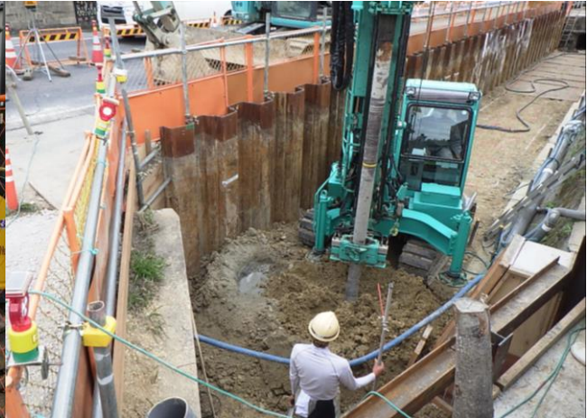
岩作中根内外新設歩道設置工事 ゼロ災害で進行中
