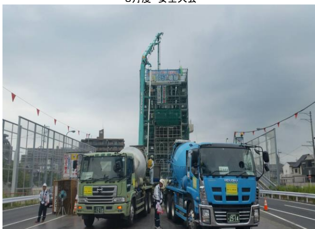
春田4橋脚 ゼロ災害で進行中
