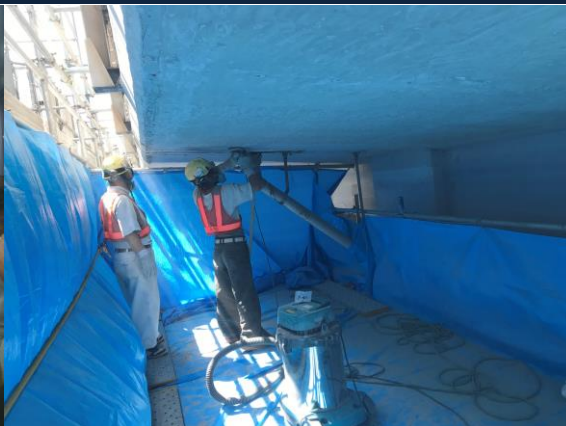
新幹線大規模改修工事 ゼロ災害で進行中
