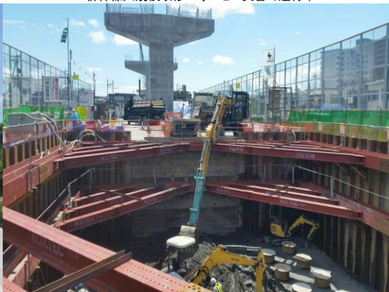
春田1橋脚 ゼロ災害で進行中
