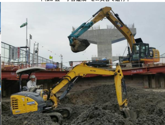
春田1橋脚 ゼロ災害で進行中
