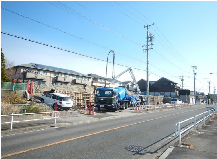
梅が丘五丁目造成工事 ゼロ災害で進行中
