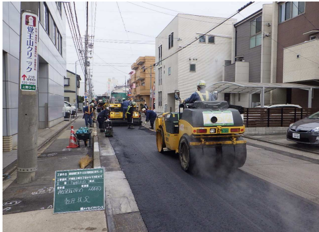
舗装道補修工事(千種-3)
