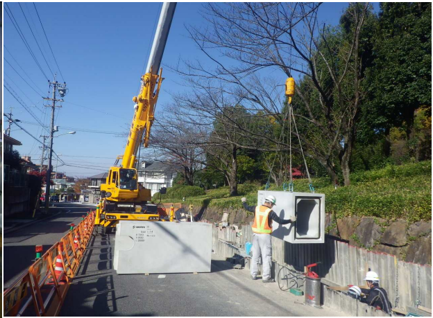
極楽排水路工事 ゼロ災害で進行中
